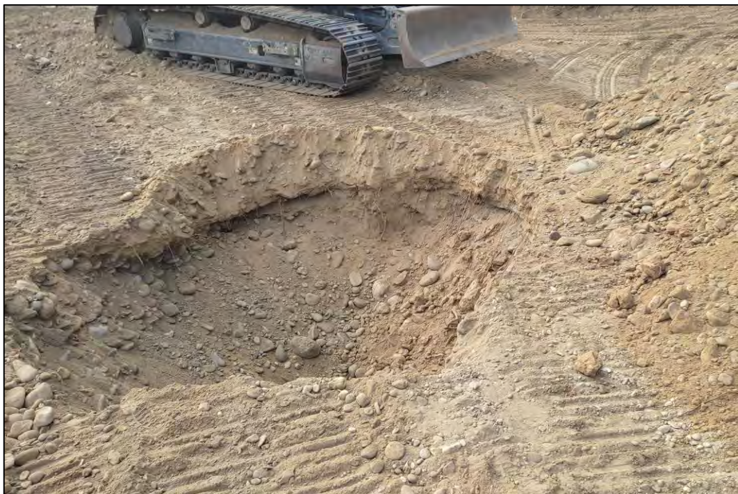
Foto 12 – Dettaglio durante i campionamenti di collaudo del fondo scavo
